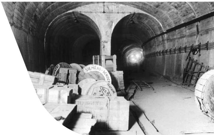
Túnel de acceso a la estación en construcción que serviría de apeadero bajo la Avenida de Mayo.
