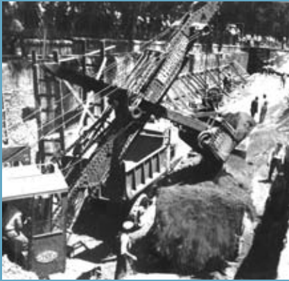
MAQUINA EXCAVADORA EN LA CONSTRUCCIÓN DE LA LÍNEA B
