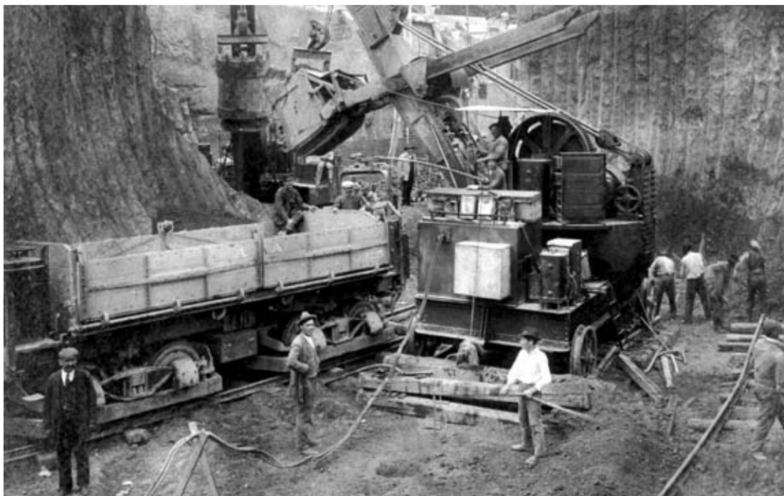
OBRAS DE CONSTRUCCIÓN DE LA LÍNEA A
