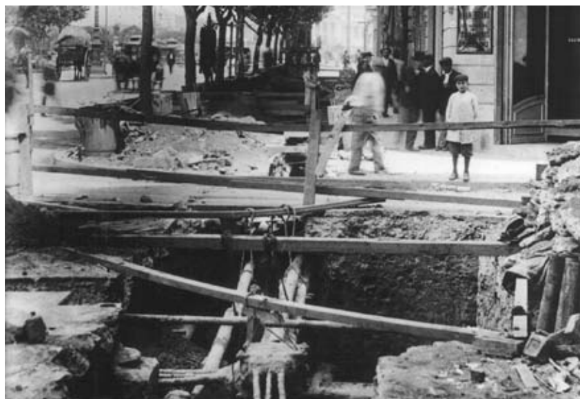
CONSTRUCCIÓN DE LA LÍNEA A. ZANJA ABIERTA EN AVENIDA DE MAYO (AÑO 1911)
