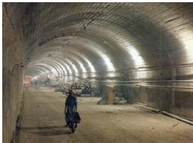
TÚNEL CARRANZA (AÑO 1976)
