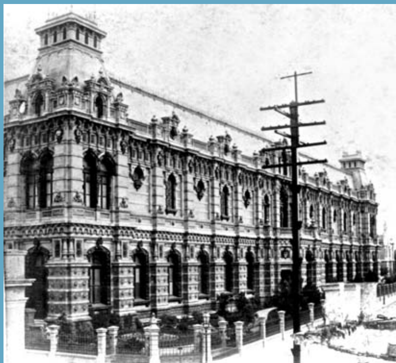
EL PALACIO DE AGUAS CORRIENTES, EN LA INTERSECCIÓN DE CÓRDOBA Y RIOBAMBA
