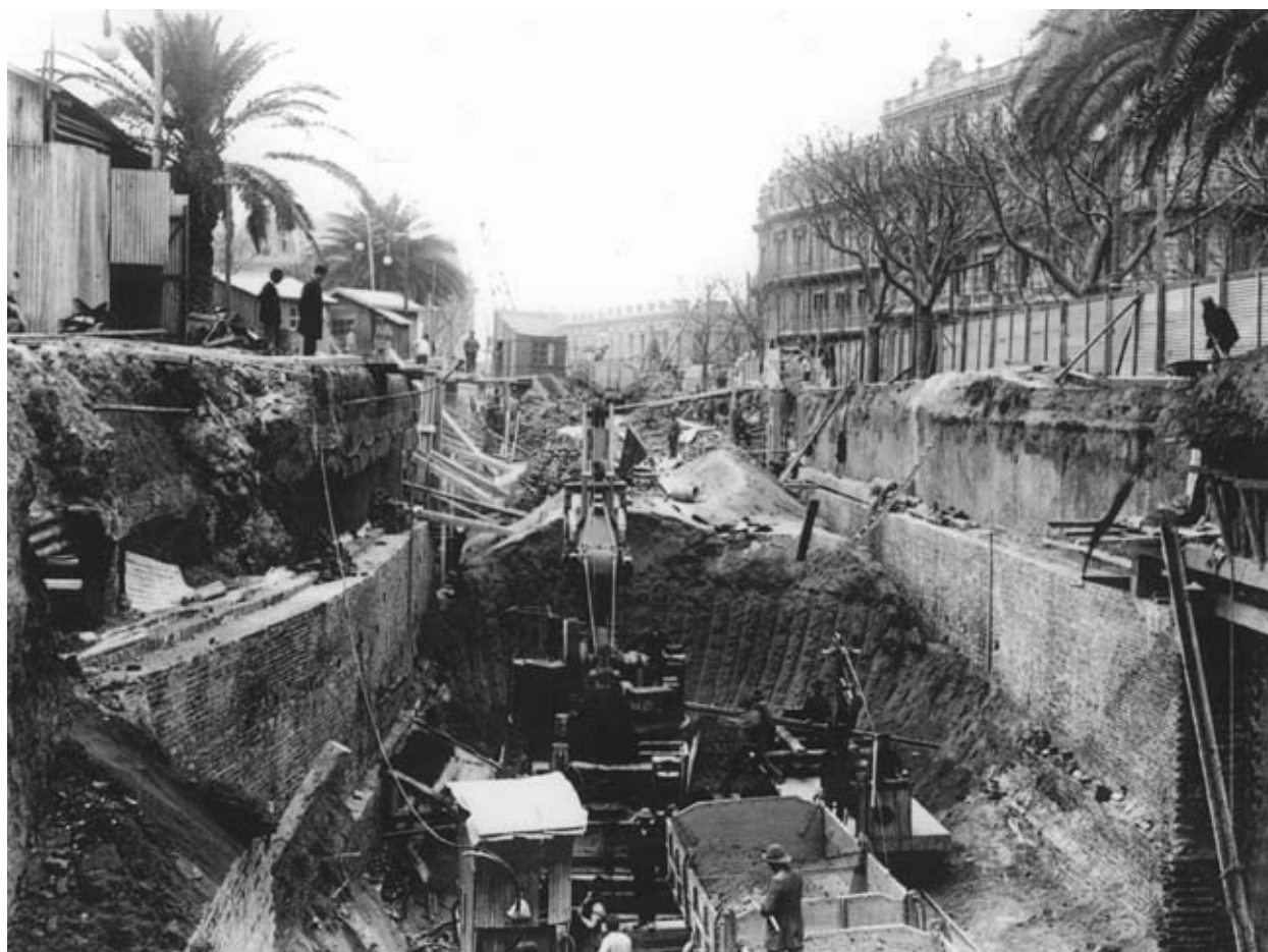
CONSTRUCCIÓN “A CIELO ABIERTO” DEL TÚNEL DE LA LÍNEA A
