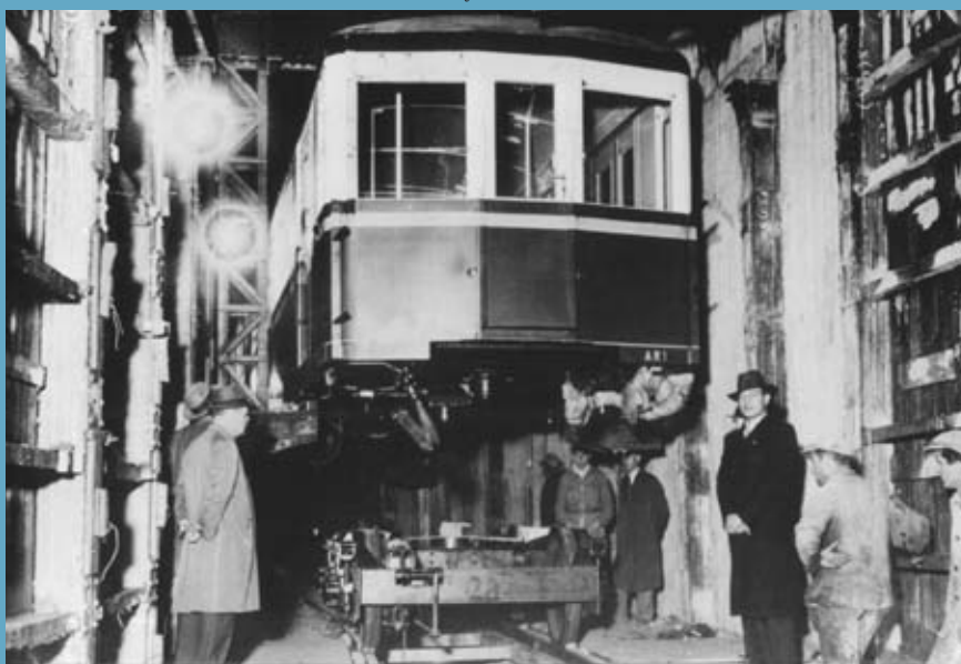
MONTAJE DEL VAGÓN SOBRE UN CHASIS DE LA CHADOPyF
