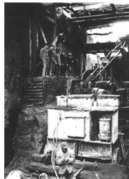
TRABAJOS DE EXCAVACIÓN DE LA COMPAÑÍA DE TRANVÍAS ANGLO- ARGENTINA
