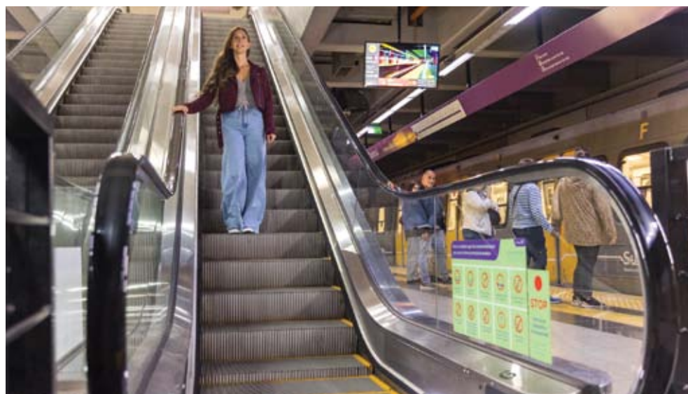
ESCALERA MECÁNICA DE LA ESTACIÓN CORREO CENTRAL CON SISTEMA DE RALENTIZACIÓN
