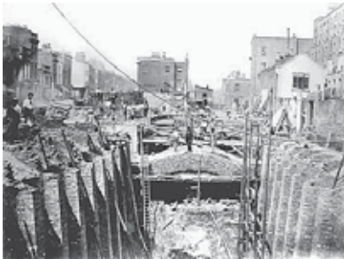
CONSTRUCCIÓN DEL SUBTERRÁNEO DE LONDRES
