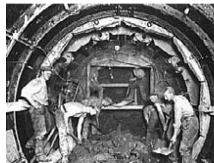
TRABAJOS EN LOS TÚNELES DE LONDRES
