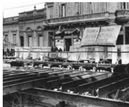
COLOCACIÓN DE VIGAS EN EL TÚNEL DE LA LÍNEA A (AÑO 1913)
