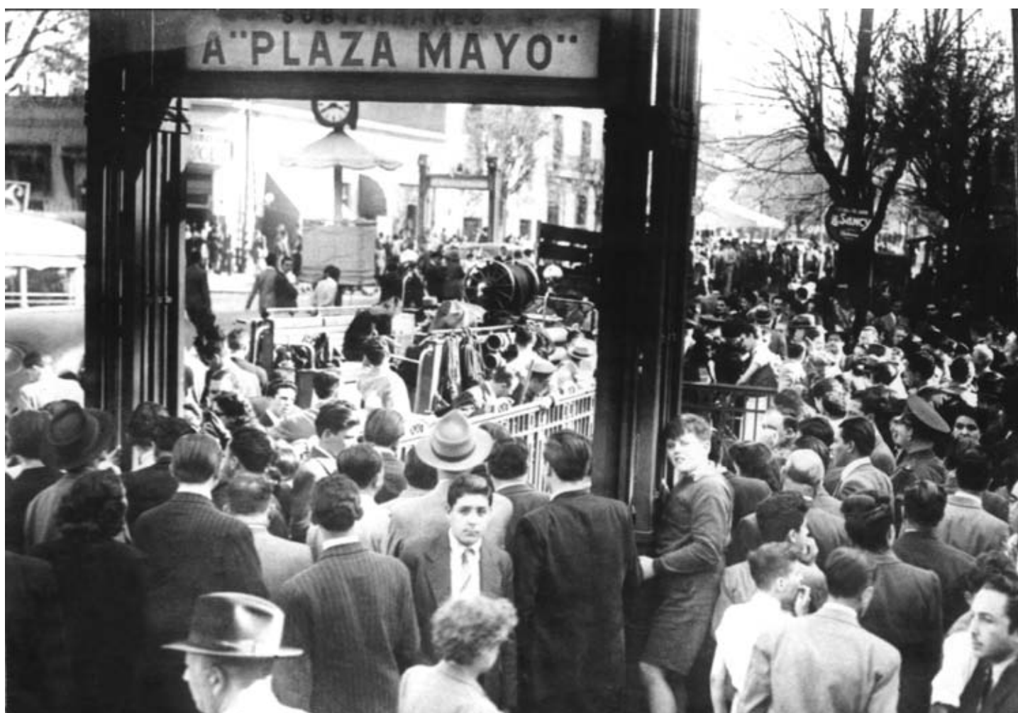
ACCESO A UNA ESTACIÓN DE LA LÍNEA A
